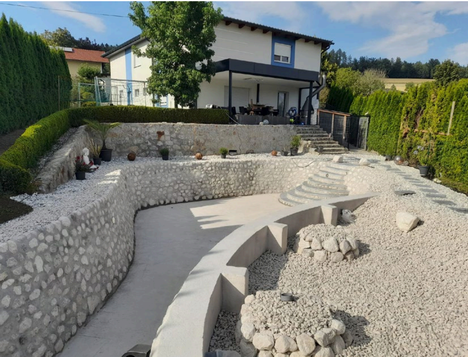
▲ Der Grund vor der Terrasse wurde abgegraben und durch eine seitlich weiterlaufende Natursteinmauer gestützt.
